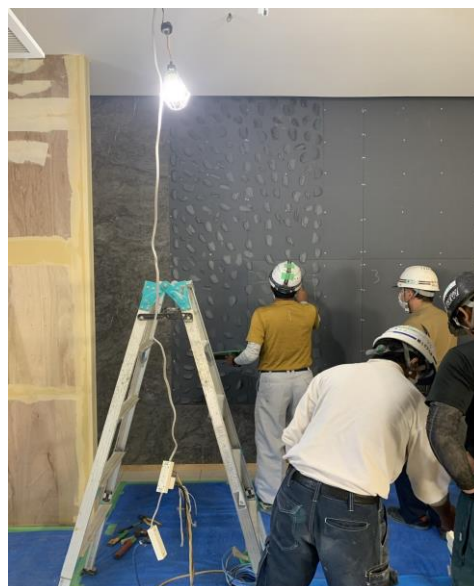
壁への施工の様子(例)
